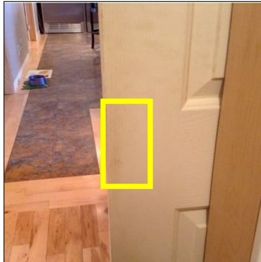
Handle required at en suite pocket door
